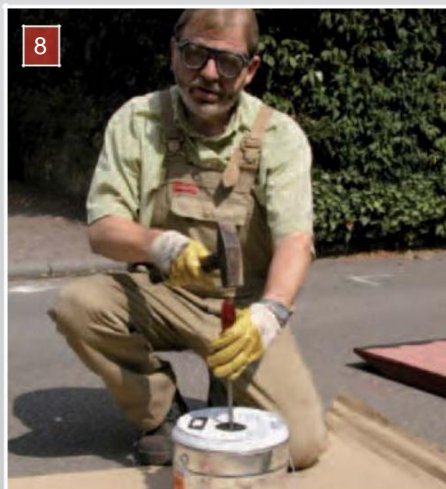
8 Die Kleber-Gebrauchsanweisung beachten, Schutzbrille und Schutzhandschuhe tragen, Mischbereich mit Folie abdecken.
