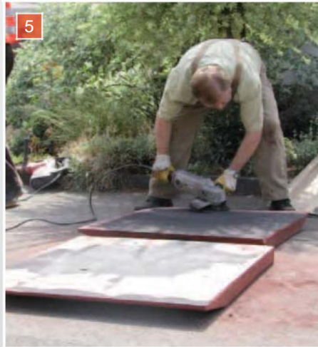
5 Rückseite mit Einhand-Winkelschleifer (Korn 40 oder größer) gut anrauen.
