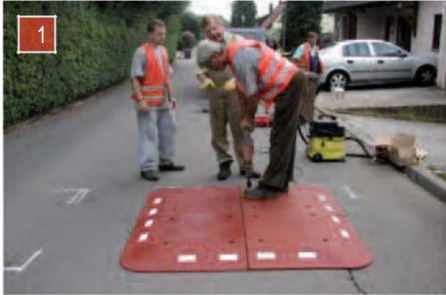
1 Maßnahme auslegen und die Bohrungen ca. 15 mm tief anbohren.
