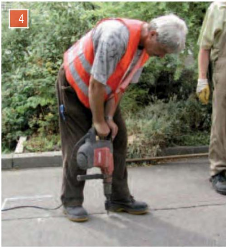
4 Alle Montagelöcher \varnothing 14 mm min. 110 mm tief bohren.
