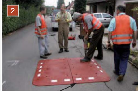
2 Außenkontur der Maßnahme mit Ölkreide anzeichnen.
