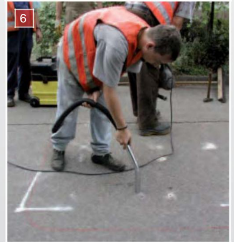
6 Bohrstaub aussaugen bzw. ausblasen.
