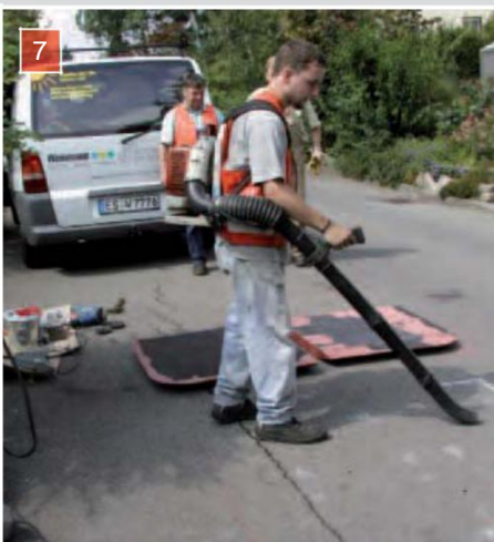
7 Klebefläche von Staub und Schmutz reinigen.
